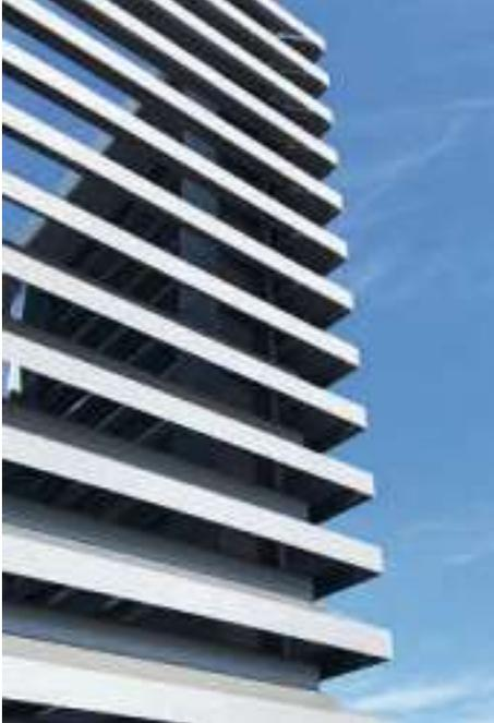
Sicht von unten: Transparenz und Luftdurchlass sind gewährleistet. Drei verschiedene Lamellenschnitte, inklusive Gehrungsschnitte, sind bei diesem Produkt frei wählbar.
