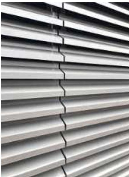
Die Profile am Dachaufbau weisen alle 6 Meter eine gleichmässige Stossausbildung auf.
