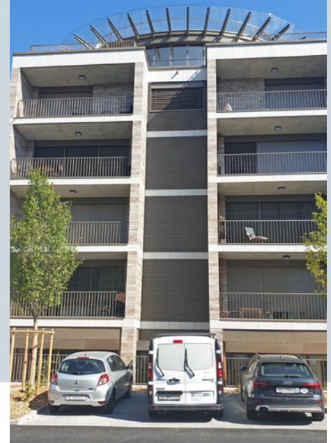
Die Lamellen führen über vier Geschosse, zweckerfüllend und ästhetisch überzeugend. Les lamelles s'étendent sur quatre étages. Solution perfectionnée et esthétiquement convaincante.
