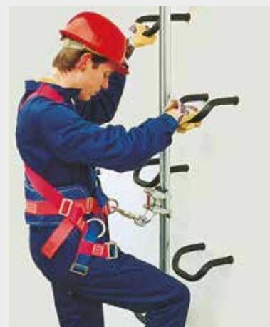
Befestigung der Fallschutzschienen zwischen den Steigeisen
