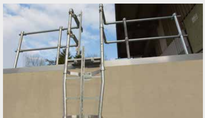
Ausstiegsgeländer (2 Sets) mit einschwenkbarer Einstiegshilfe
